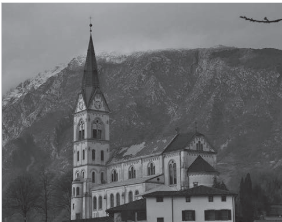
Drežnica, župnijska cerkev Srca Jezusovega, zunanjščina (foto: Franci Lazarini)
